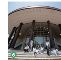
6 体育館兼講堂 Gymnasium and auditorium
